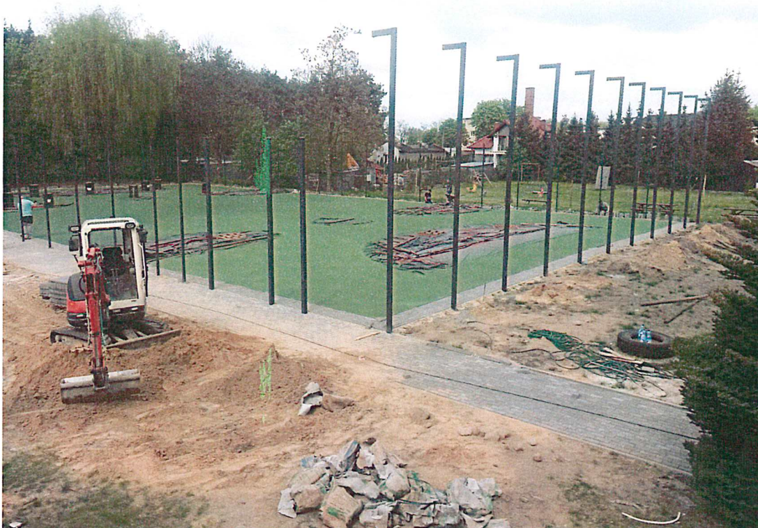
Zdj. 5 Roboty budowlane przy budowie boiska wielofunkcyjnego w Kołaczkowie
