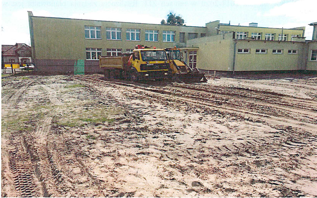
Zdj. 3 Roboty budowlane przy rozbudowie Szkoły Podstawowej w Turze
