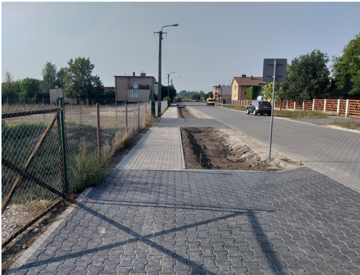
Fot. nr 15: Budowa drogi i chodnika w ciągu ulicy Klonowej w Zamościu.
