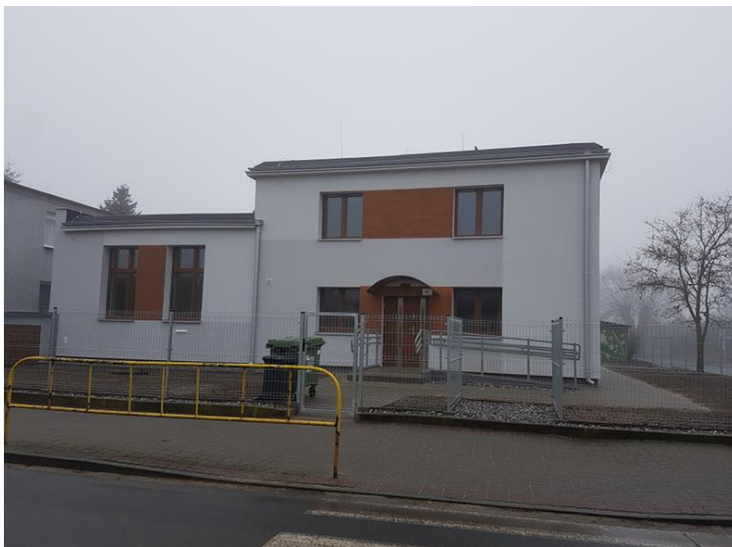
Fot. nr 10: Przebudowa „Domu Harcerza” w Szubinie.
