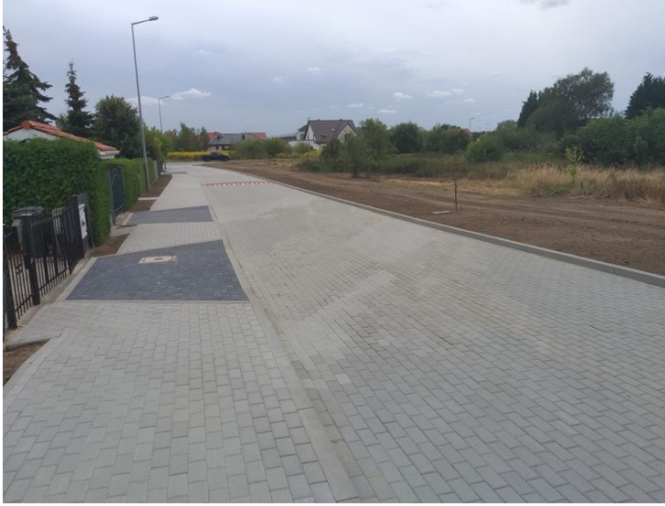
Fot. nr 14: Przebudowa ulicy Lipowej w Szubinie.
