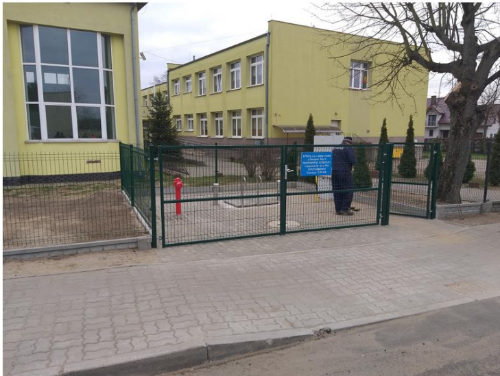
Fot. nr 17: Zakończenie budowy sieci kanalizacyjnej w Turze.
