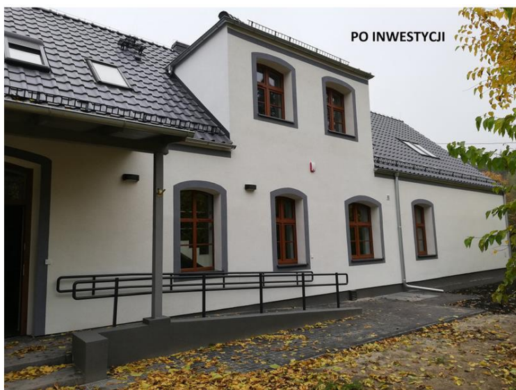
Fot. nr 11: Budowa Centrum Astronomiczno- Kulturalno- Dydaktycznego w Niedźwiadach.
