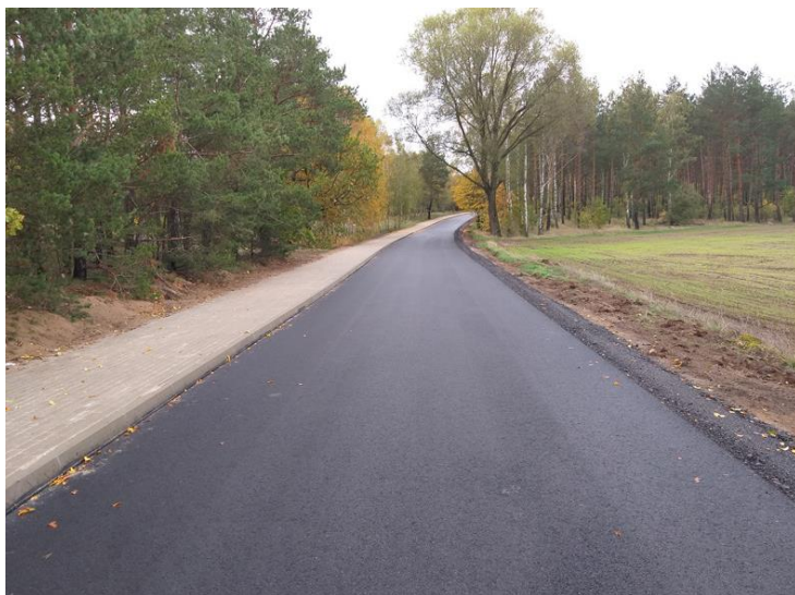
Fot. nr 12: Budowa drogi Tur-Brzózki.
