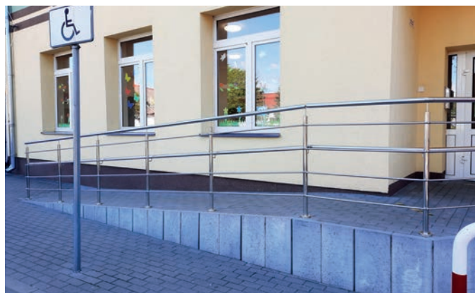
Fot. 27 podjazd i schody, Przedszkole nr 3 w Szubinie
