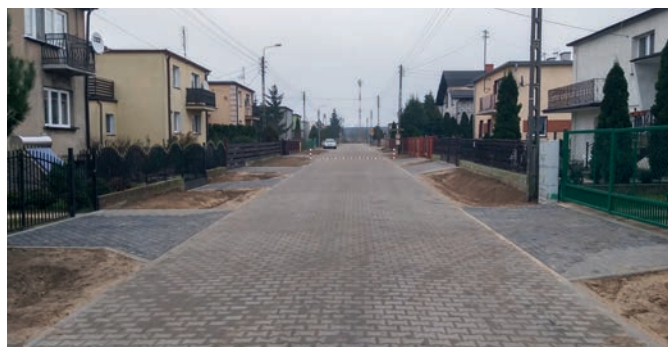
Fot. 10 ul. Pałucka w Kowalewie po remoncie
