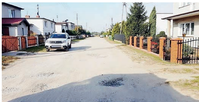
Fot. 9 ul. Pałucka w Kowalewie przed remontem
