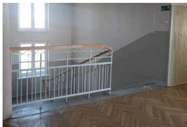
Fot. 28 Prace remontowe korytarzy, renowacja parapetów oraz poręczy w SP2 w Szubinie Źródło: SP2 w Szubinie
