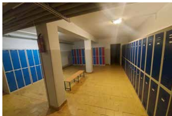
Fot. 24 Remont szatni w SP1 przy ul. Grudzielskiego 21 Źródło: SP1 w Szubinie
