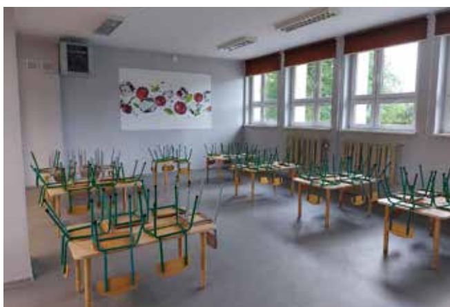
Fot. 23 Remont jadalni w oddziałach zerowych w SP1 przy ul. św. Marcina
