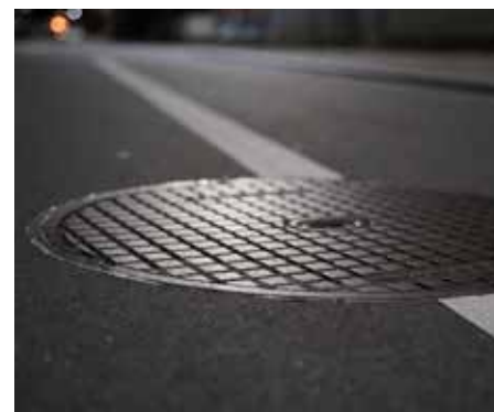
Fot. 22 Właz kanalizacyjny
