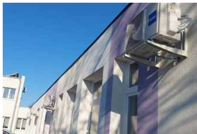
Fot. 31 Zakup i montaż klimatyzacji w pomieszczeniach Szkoły Podstawowej w Kowalewie Źródło: SP w Kowalewie
