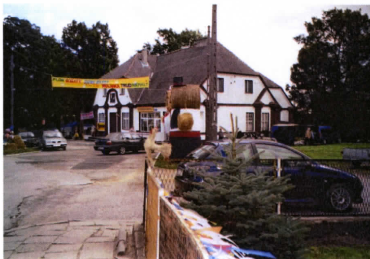
Fot. Budynek dawnego pensjonatu
