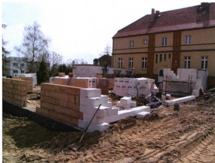
Fot. Rozbudowa szkoły
