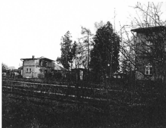
Fot. Widok na tory kolejowe i budynki dworcowe
